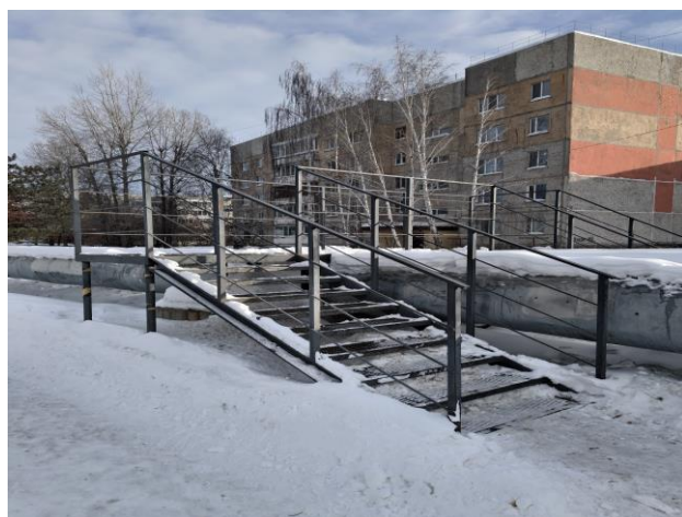
Переход после замены
